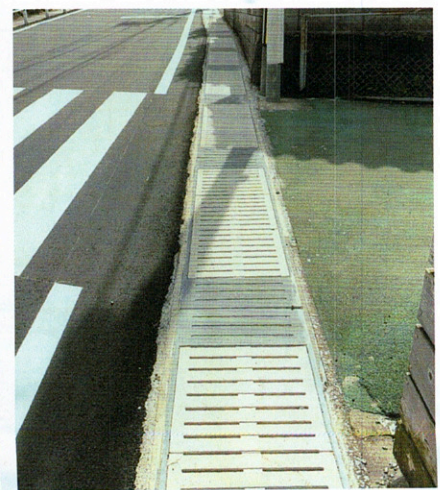
鹿児島地域振興局 単県道路整備(舗装補修) 工事(坂之上工区)
