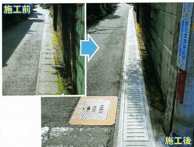
熊本県 八代市役所 日奈久浜町日奈久下東町線 側溝蓋修繕工事
