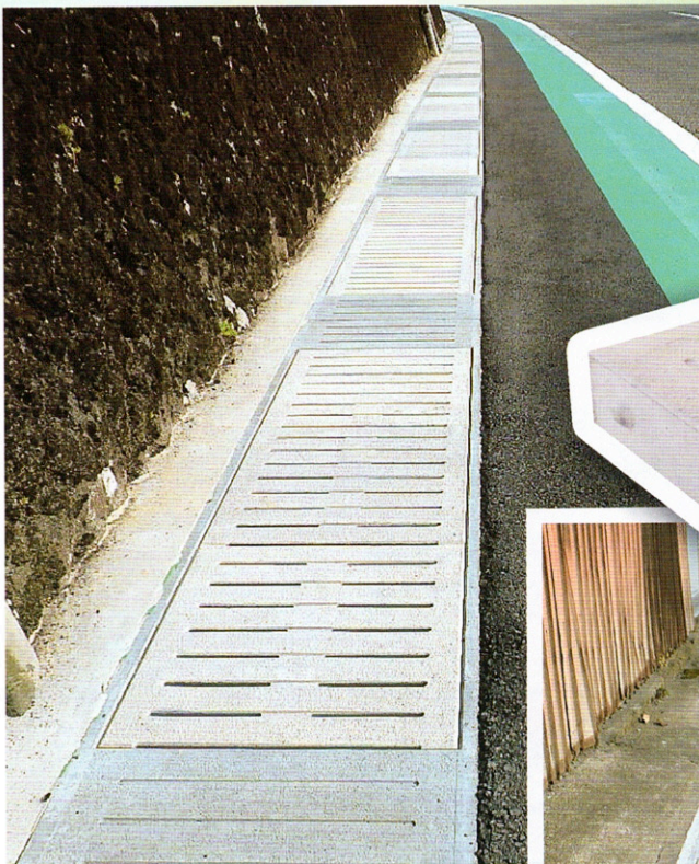
球磨地域振興局 坂本人吉線単県側溝整備(地道債)工事
